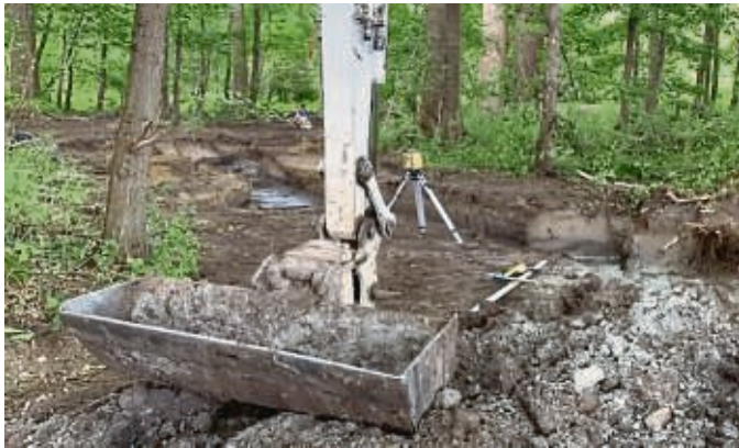
Die ersten Meter des neuen Ahse-Verlaufs wurden bereits ausgehoben.
