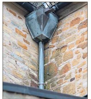
Der Wasserkasten an der Nordseite ist ebenso undicht wie an der Ostseite. Am Mauerwerk sind deutliche Wasserflecken sichtbar.
