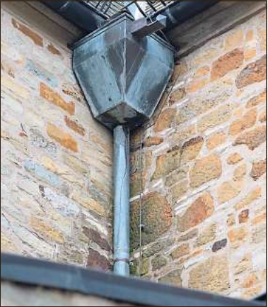
Der Wasserkasten an der Nordseite ist ebenso undicht wie an der Ostseite. Am Mauerwerk sind deutliche Wasserflecken sichtbar.
