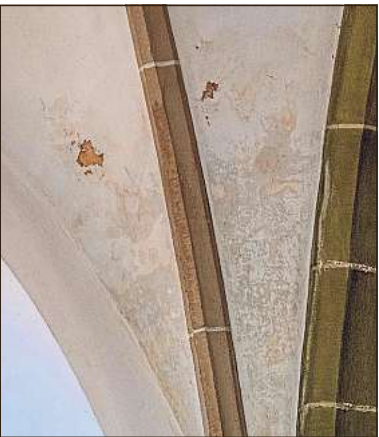
An der Decke platzt bereits der Putz ab.
