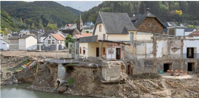
Der Ortskern von Rech im Ahrtal wurde weitgehend zerstört.
