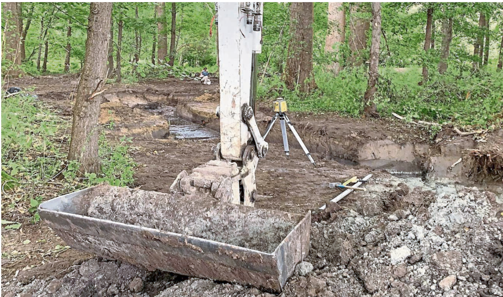
Die ersten Meter des neuen Ahse-Verlaufs wurden bereits ausgehoben.
