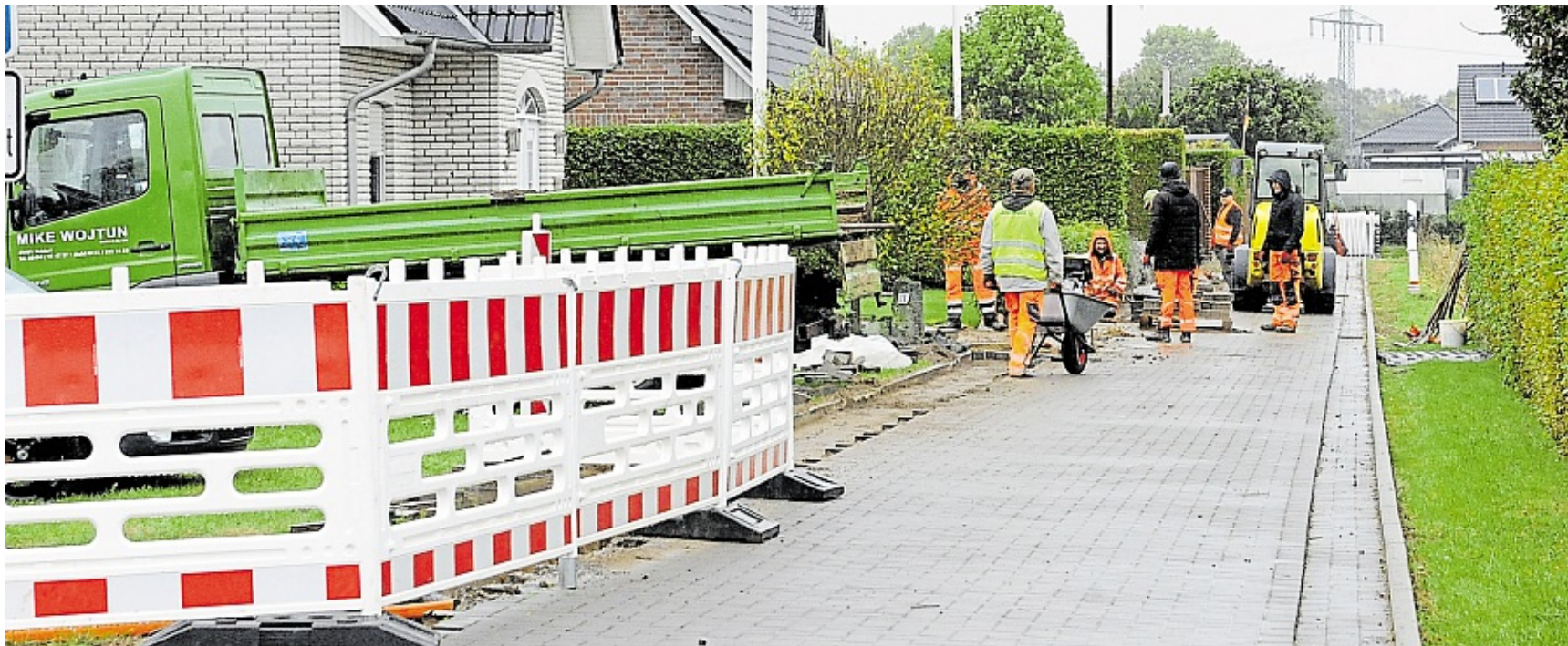
Die Leitungsbauer arbeiten sich gerade durch Alfhausens Eschsiedlungen.
