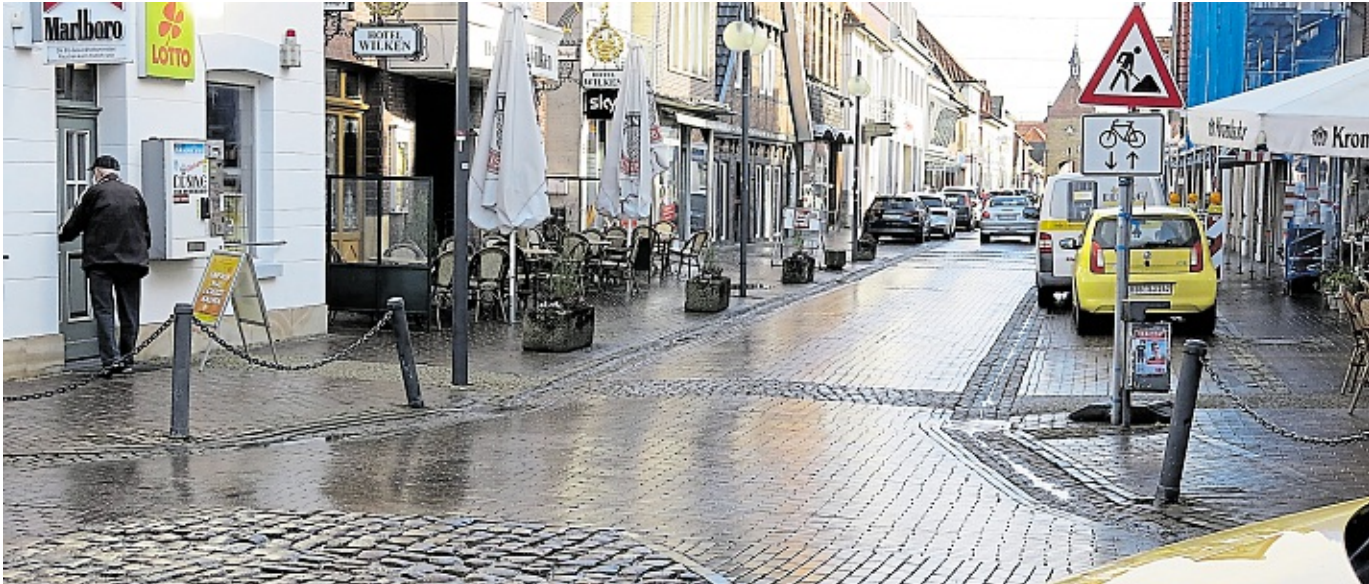
Im Kreuzungsbereich Bahnhofstraße und Burgstraße werden an der Einfahrt zur Großen Straße im nächsten Jahr automatisch versenkbare Poller installiert – ebenso im Bereich des Hohen Tores am anderen Straßenende.
