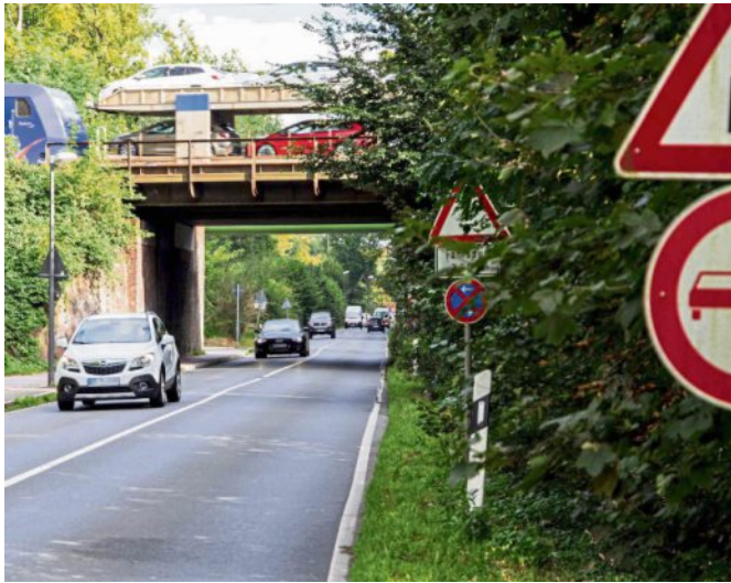
Engpass: die Zugbrücke samt Unterführung.
