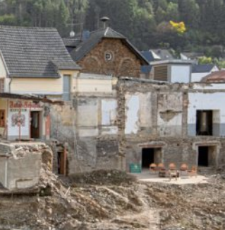
Der Ortskern von Rech im Ahrtal wurde weitgehend zerstört.
