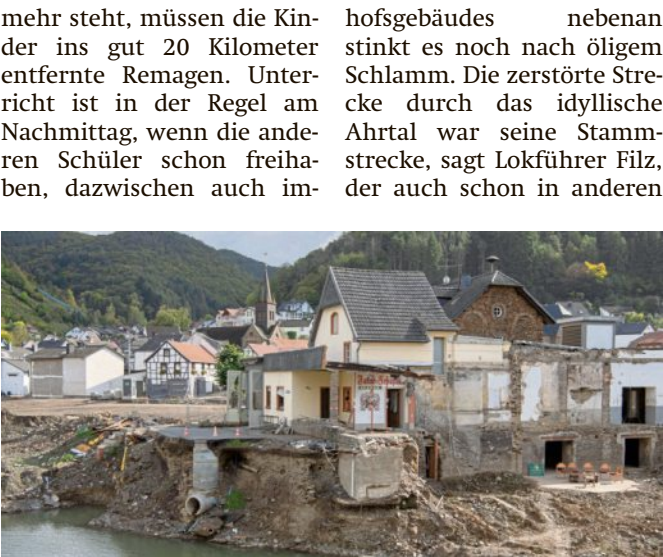
Der Ortskern von Rech im Ahrtal wurde weitgehend zerstört.
