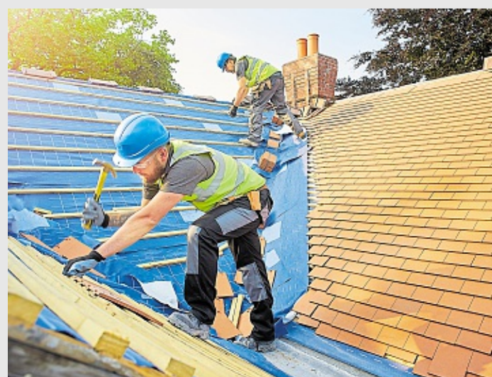
Eine fachkundige Umsetzung von Dacharbeiten leisten in der Regel nur Dachdeckermeisterbetriebe aus der Region. Foto: iStock
