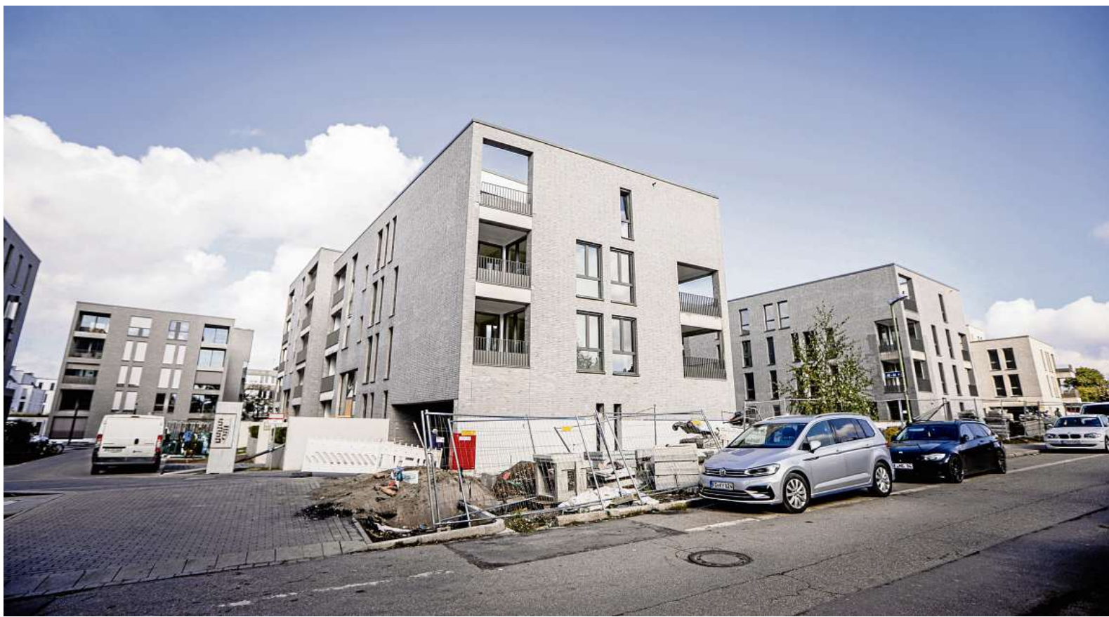
Die Arbeiten im Baugebiet Parc Dunant kommen voran und sollen bis Jahresende abgeschlossen sein.
