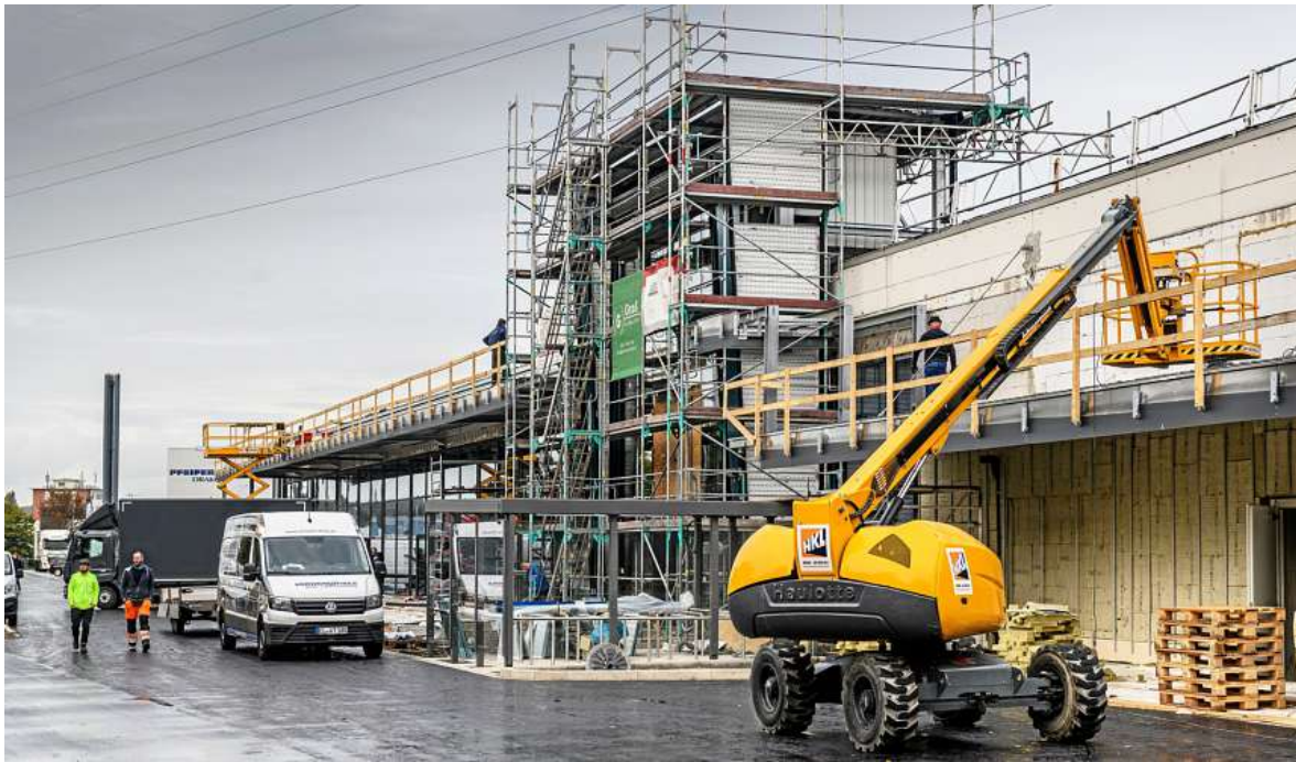
Ein Bild aus dieser Woche zeigt noch reichlich Baustellenbetrieb für das neue Hafencenter an der Weseler Straße. In der ehemaligen Real-Filiale wird der örtliche Edeka-Händler Paschmann eröffnen.
