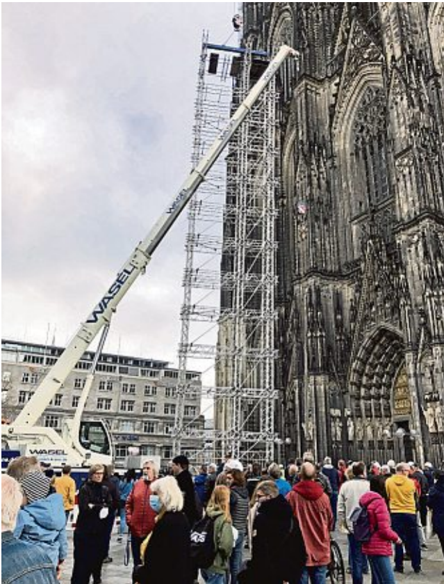
Viele Schaulustige verfolgten den Abbau auf der Domplatte.
