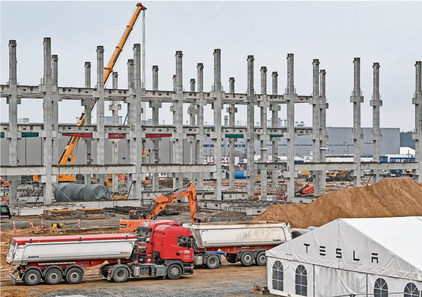
Schon in wenigen Wochen sollen hier die ersten Teslas gebaut werden.
