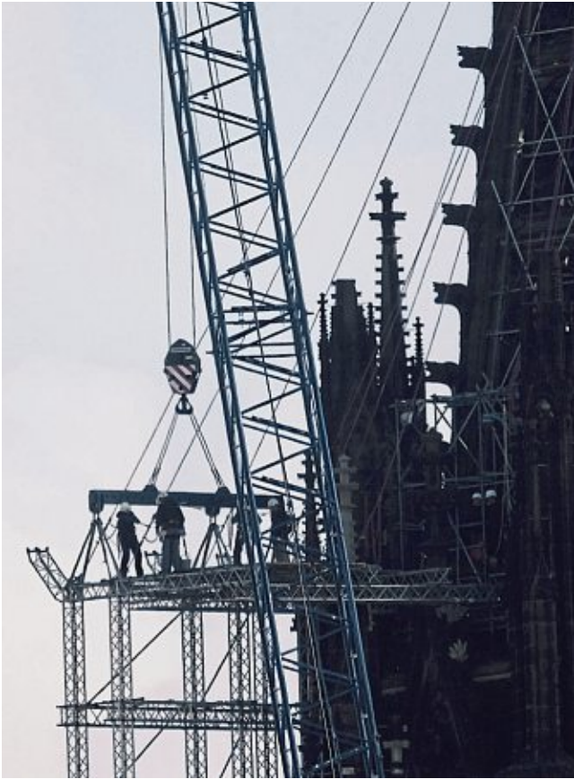
Die Gerüstbauer arbeiten in schwindelerregender Höhe.
