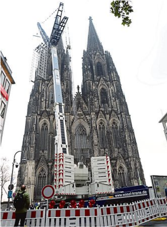
Der Spezialkran wiegt 290 Tonnen – zu schwer für die Domplatte
