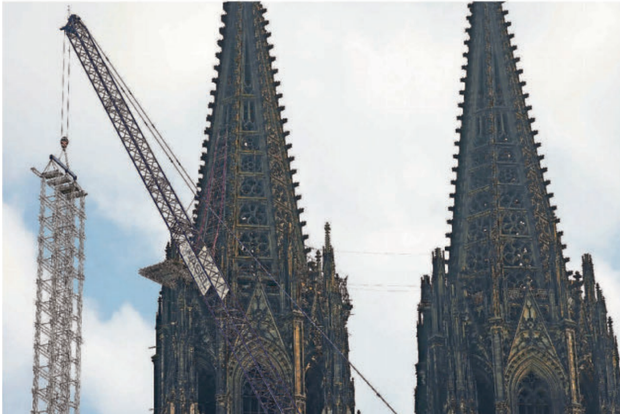
Ein Teil des Baurüstes wird vor dem Dom heruntergelassen. Wenn das 30 Meter hohe Gerüst weg ist, wird die Westfassade des Doms mit dem Hauptportal erstmals seit zehn Jahren wieder unverhüllt zu sehen sein.
