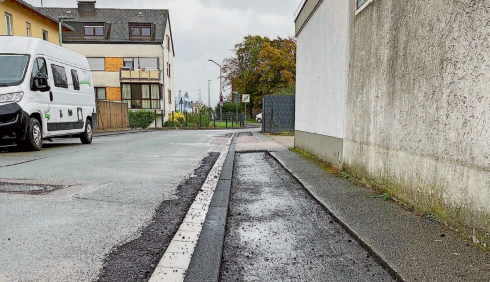
In der Adam-Stegerwald-Straße wird der Bürgersteig erneuert. Seit zwei Wochen tut sich dort nichts mehr.
