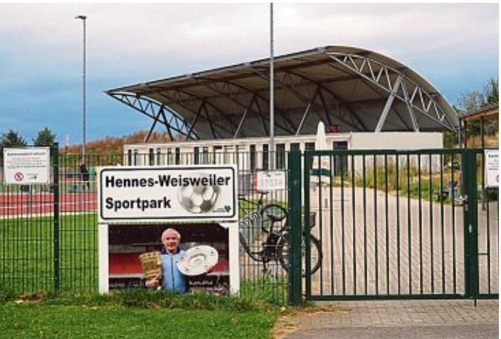
Das markante Dach am Vereinsheim des SC Germania dient auch als Lärmschutz. Foto: Jürgensonn
