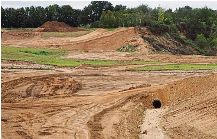
Die Arbeit in dem Krater, den das Hochwasser gerissen hat, gehen voran. Die Abbruchkante ist größtenteils zu einer Böschung angeschüttet, Rohre sollen bei Starkregen das Wasser ableiten.
