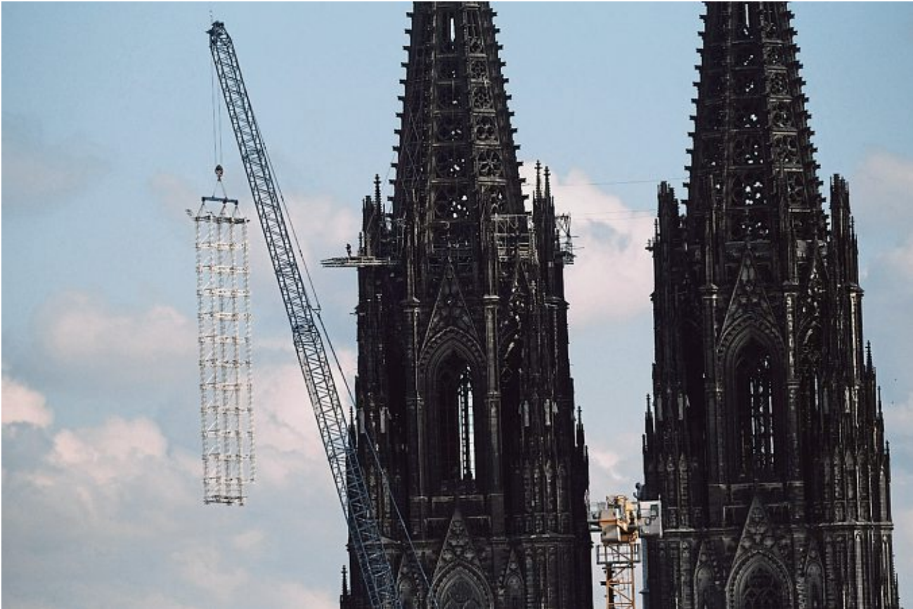
Ab 13.40 Uhr war die Westfassade vom Gerüst befreit.
