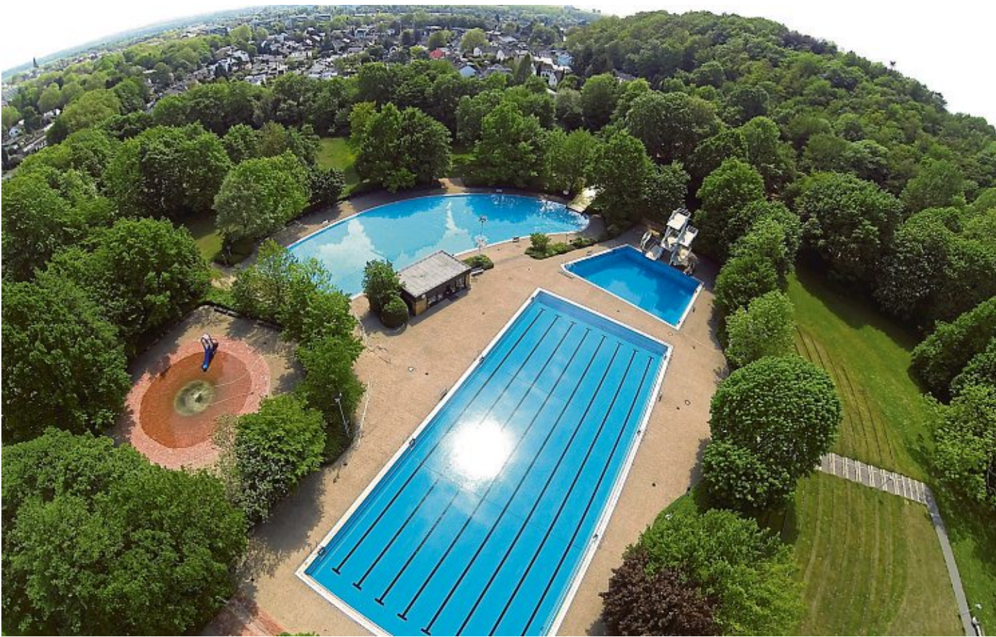
Im Terrassenfreibad steht eine umfangreiche Sanierung auf dem Programm.
