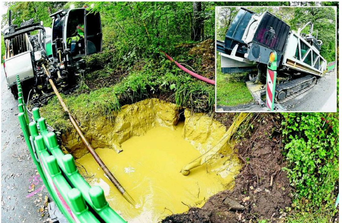
Im Bereich „Zum Angelsee“ in St. Arnold laufen aktuell Arbeiten des Verteilnetzbetreibers Westnetz. Insgesamt werden auf einer Länge von acht Kilometern Kabel verlegt. Durchgeführt wird ein Großteil der Arbeiten im Spülbohrverfahren. Fotos: Rapreger
