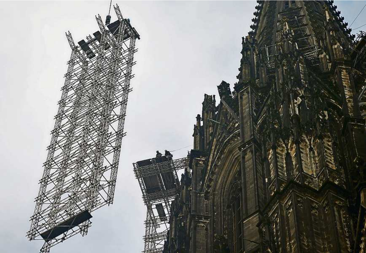
Ein Teil des Gerüsts am Kölner Dom schwebt hier sicher am Kranhaken hinab in die Tiefe.
