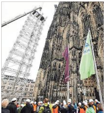
Arbeiter und Schaulustige verfolgen das Herunterlassen eines Teils des Baugerüsts am Dom. Foto: dpa
