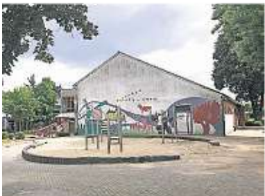
Die Turnhalle im Schulzentrum Hünxe wird abgerissen. FOTO: P.N.
