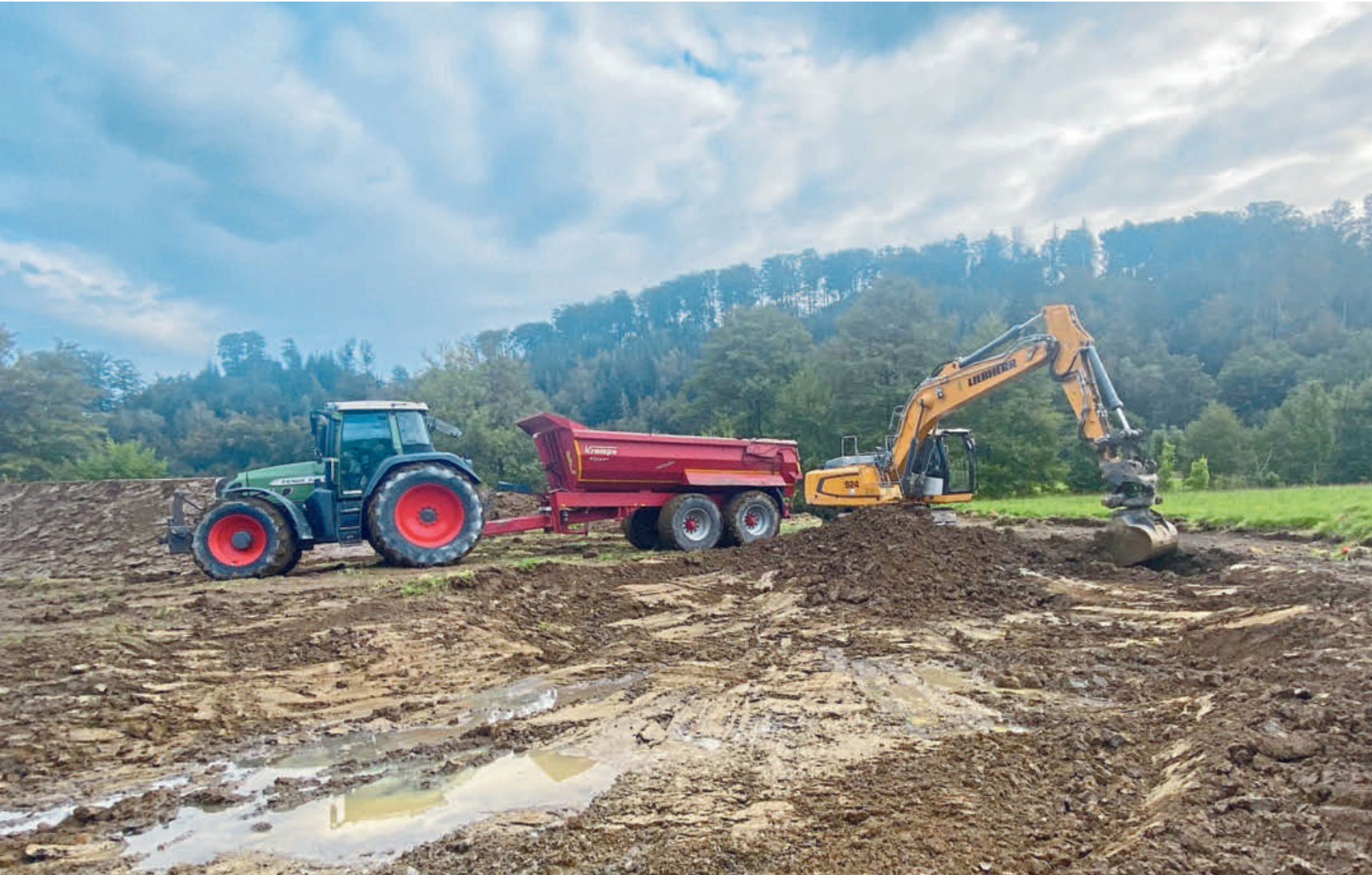
Die zweite Bauphase zur Renaturierung der Alme hat begonnen. Bis Ende Dezember sollen die Arbeiten abgeschlossen sein. Investiert werden rund 430.000 Euro.
