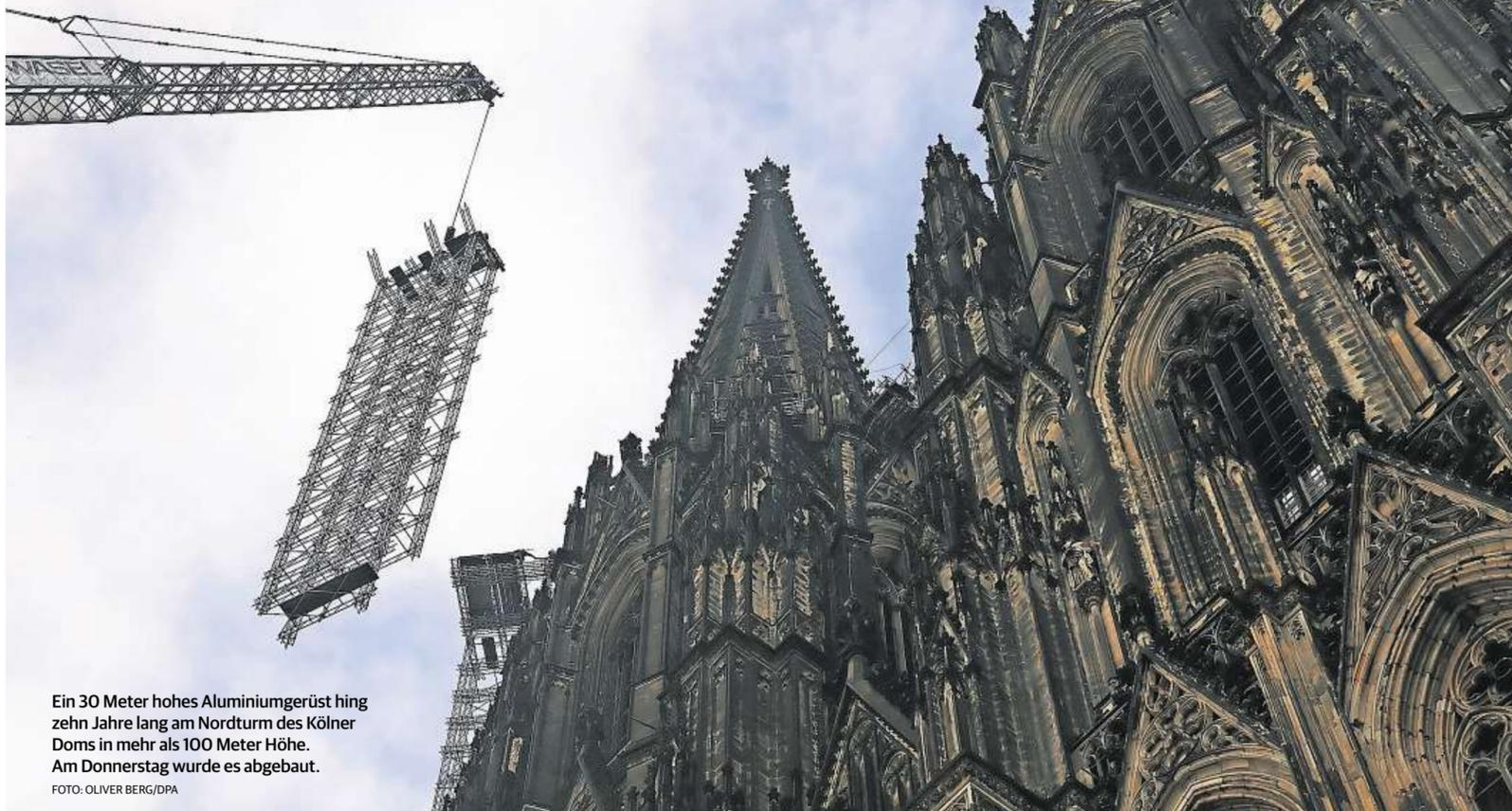
Ein 30 Meter hohes Aluminiumgerüst hing zehn Jahre lang am Nordturm des Kölner Doms in mehr als 100 Meter Höhe. Am Donnerstag wurde es abgebaut.
