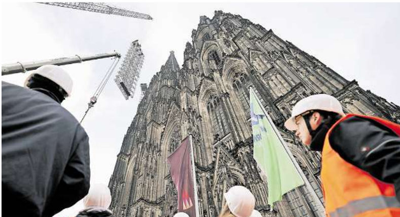
Kein Baugerüst mehr! Das Gerüst am Dom wurde abgebaut. FOTOS: OLIVER BERG/DPA
