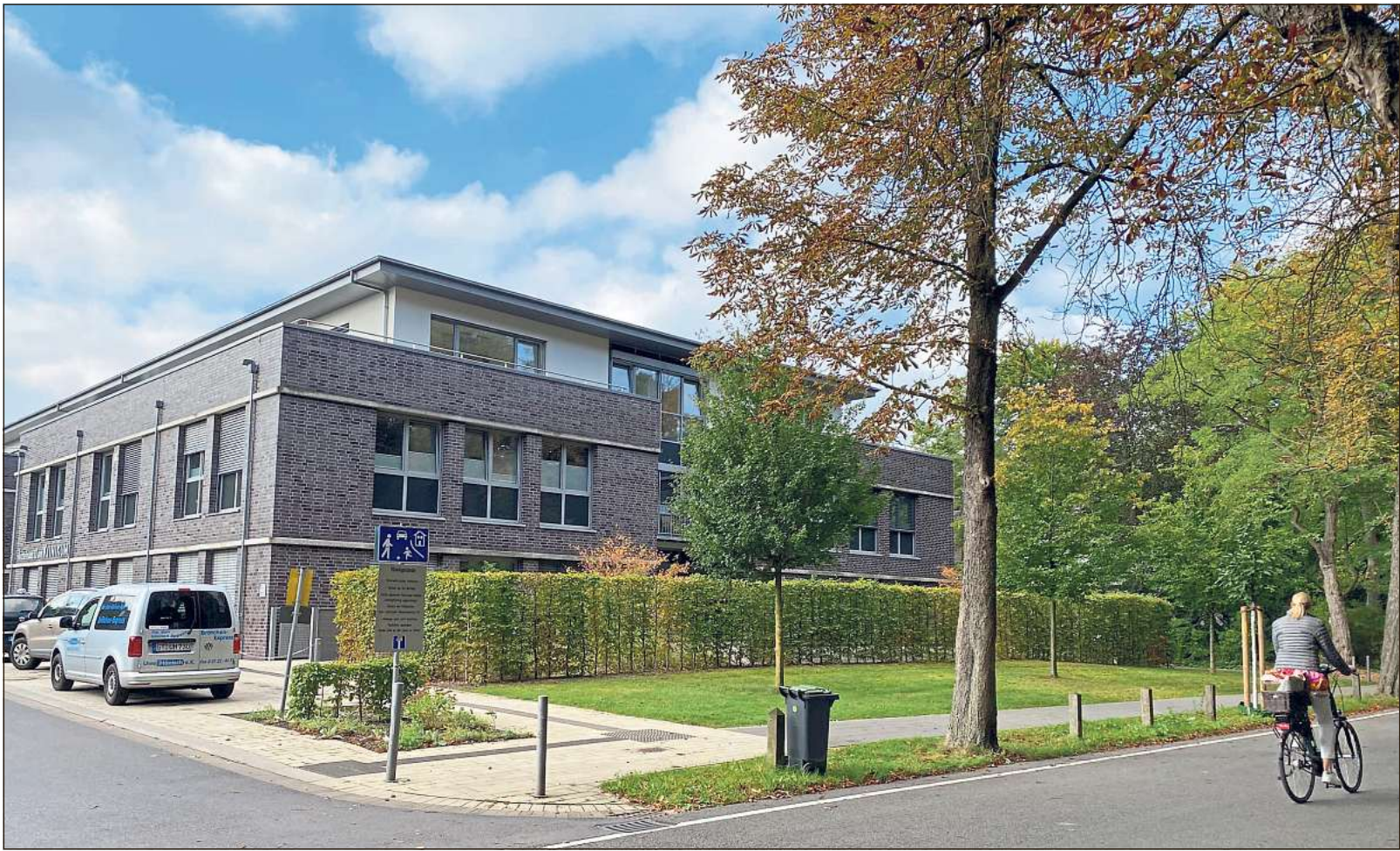
Hinter dem Ärztehaus II entsteht die neue Verwaltung des Klinikums Gütersloh: Der Beginn der Maßnahme ist für April geplant. Der Rat entscheidet heute über ein erweitertes Gesellschafterdarlehen.
