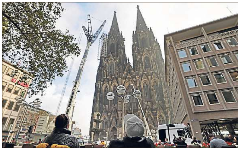
Freie Sicht auf die Westfassade des Kölner Doms – das erste Mal in zehn Jahren. Das 30 Meter hohe Hängegerüst am Nordturm wurde gestern von einem Baukran auf den Boden gehoben. Weltchronik/Foto: dpa
