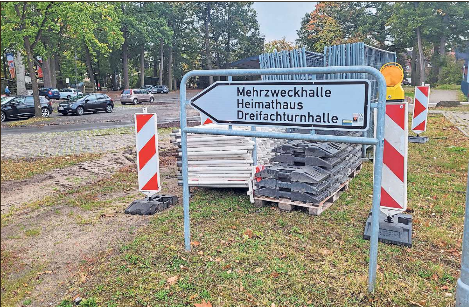
Die Arbeiten zur Umgestaltung des Heimathofs sind laut Heinz Austermann von der Stadtverwaltung gestartet. Bevor der Bagger richtig loslegen kann, wurde am Wochenende noch eine laut Gutachter nicht standsichere Eiche gefällt. Jetzt wird erst einmal die Feuerwehruzufahrt zur Mehrzweckhalle geschaffen. Fotos: Aundrup
