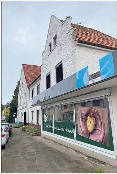
Mehrere Ideen lieferten die Kaunitzer für das Areal an der Fürstenstraße. Das Grundstück, das früher der Elli-Markt genutzt hat, gehört der Stadt Verl und soll überplant werden.
