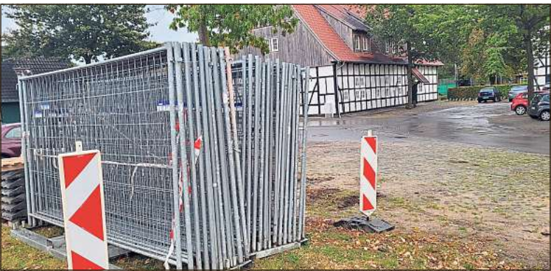
Die Absperrzäune standen am Mittwochabend bereits auf dem Heimathof – ebenso wie ein Bagger.
