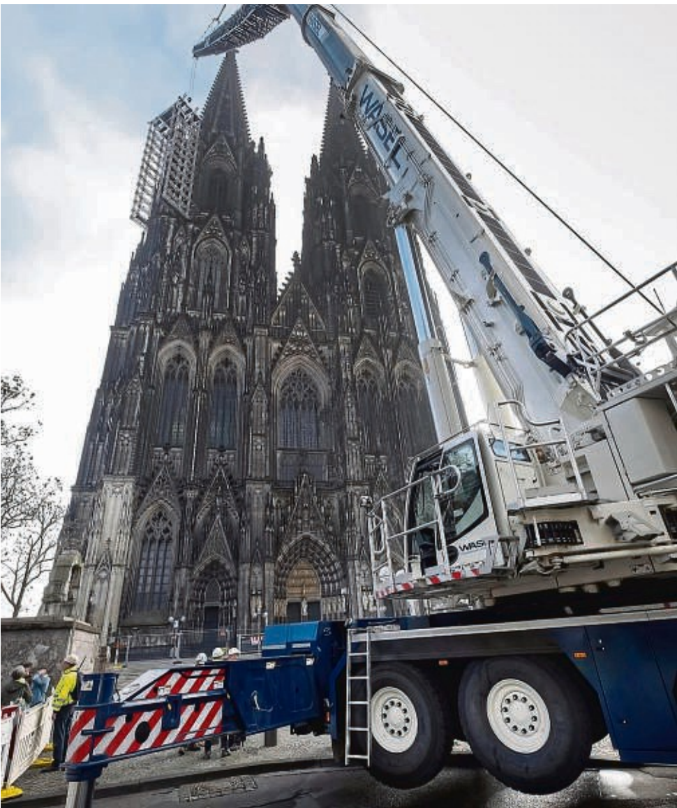
Die Westfassade des Kölner Doms ist erstmals seit zehn Jahren wieder ohne großes Gerüst zu sehen. Mit einem Schwerlastkran wurde am Donnerstag ein 30 Meter hohes Hängegerüst in mehr als 100 Metern Höhe am Nordturm abgenommen.
