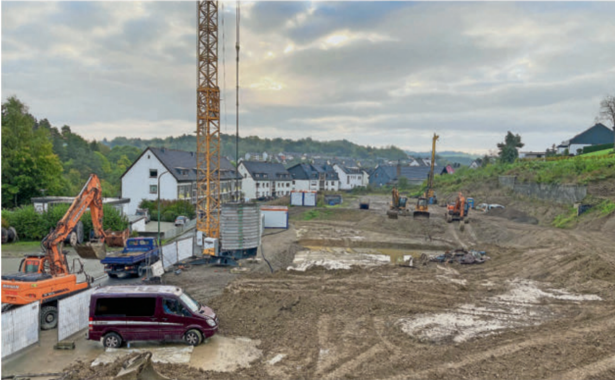
Auf der Baustelle in Daun, wo die sogenannte Junior-Uni entsteht, ist eine Fünf-Zentner-Fliegerbombe gefunden worden.
