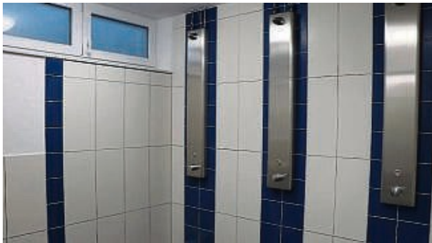
Einer der neuen Duschräume in der Turnhalle.
