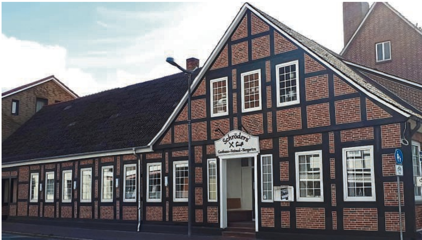
Die Fachwerkfassade des historischen Gebäudes im Ortskern von Barnstorf wurde komplett saniert.
