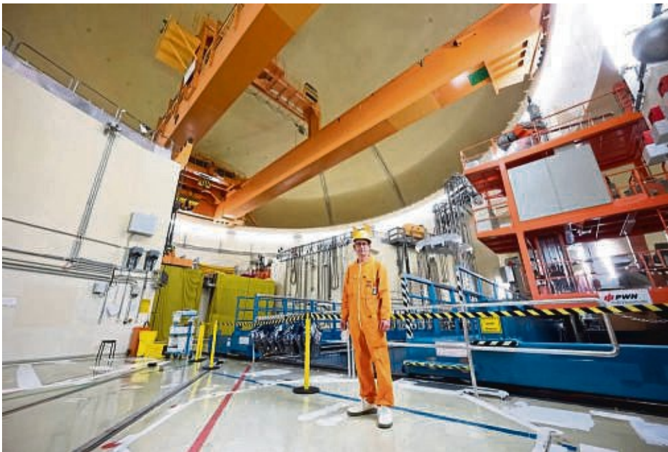
Alles muss raus: Dominik van Meegen, Leiter Stabstelle Rückbauplanung, steht im Reaktorgebäude vom Atomkraftwerk Grohnde.
