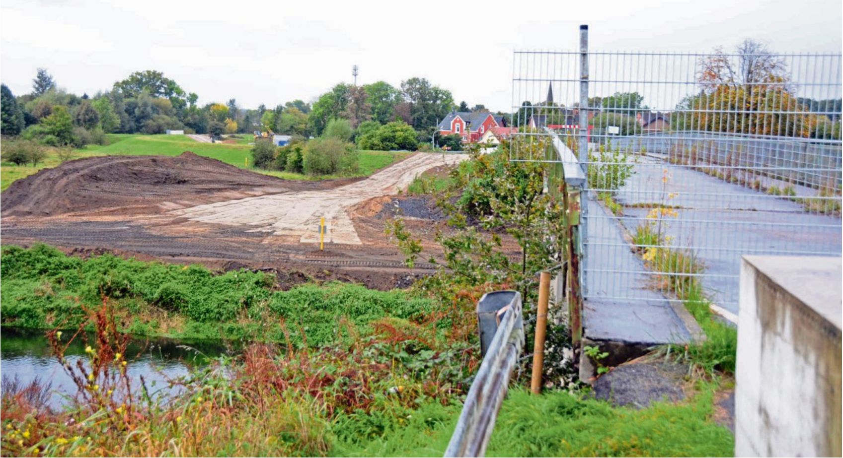
Die vorbereitenden Arbeiten für den Neubau der Lippebrücke in Ahsen sind angelaufen. So ist in den vergangenen Tagen eine neue Zufahrt geschaffen worden.
