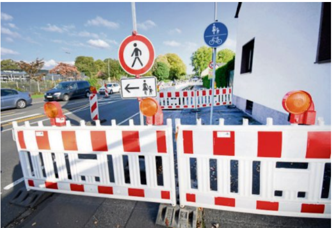
Auf der Recklinghäuser Straße (B225) sorgt derzeit eine Baustelle für Verkehrsbehinderungen. FOTO MEIKE HOLZ
