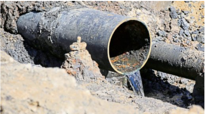
Teile der Kanalisation in vier Straßen in Drewer lässt der Zentrale Betriebshof (ZBH) der Stadt Marl ab nächster Woche erneuern. FOTO DPA (SYMBOLBILD)
