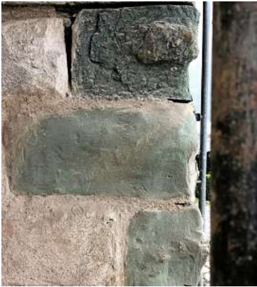
Grünlich verwittert ist der Sandstein der Klosterkirchen-Chorfassade. Im Bild wurde unten bereits eine zweite Schicht einer sogenannten Kalkschlämme aufgetragen (matte Steine), um weiteren Schaden zu verhindern.
