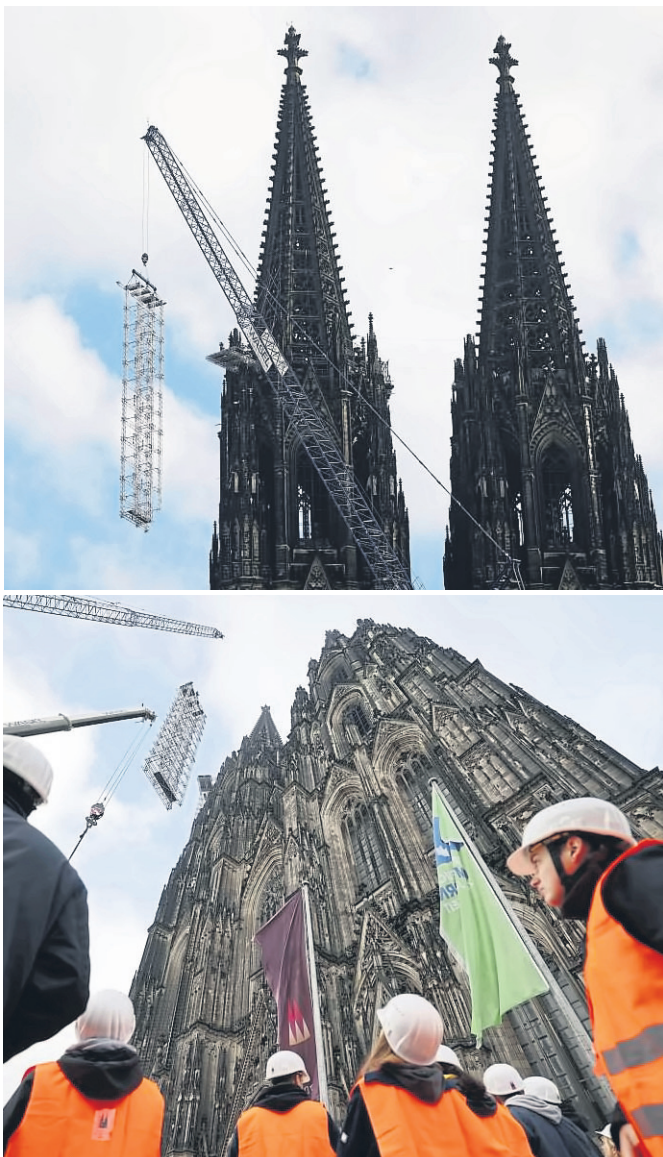
Die Westfassade des Kölner Doms ist erstmals seit zehn Jahren wieder ohne großes Gerüst zu sehen. Mit einem Schwerlastkran wurde am Donnerstag ein 30 Meter hohes Hängegerüst in mehr als 100 Metern Höhe am Nordturm abgenommen.
