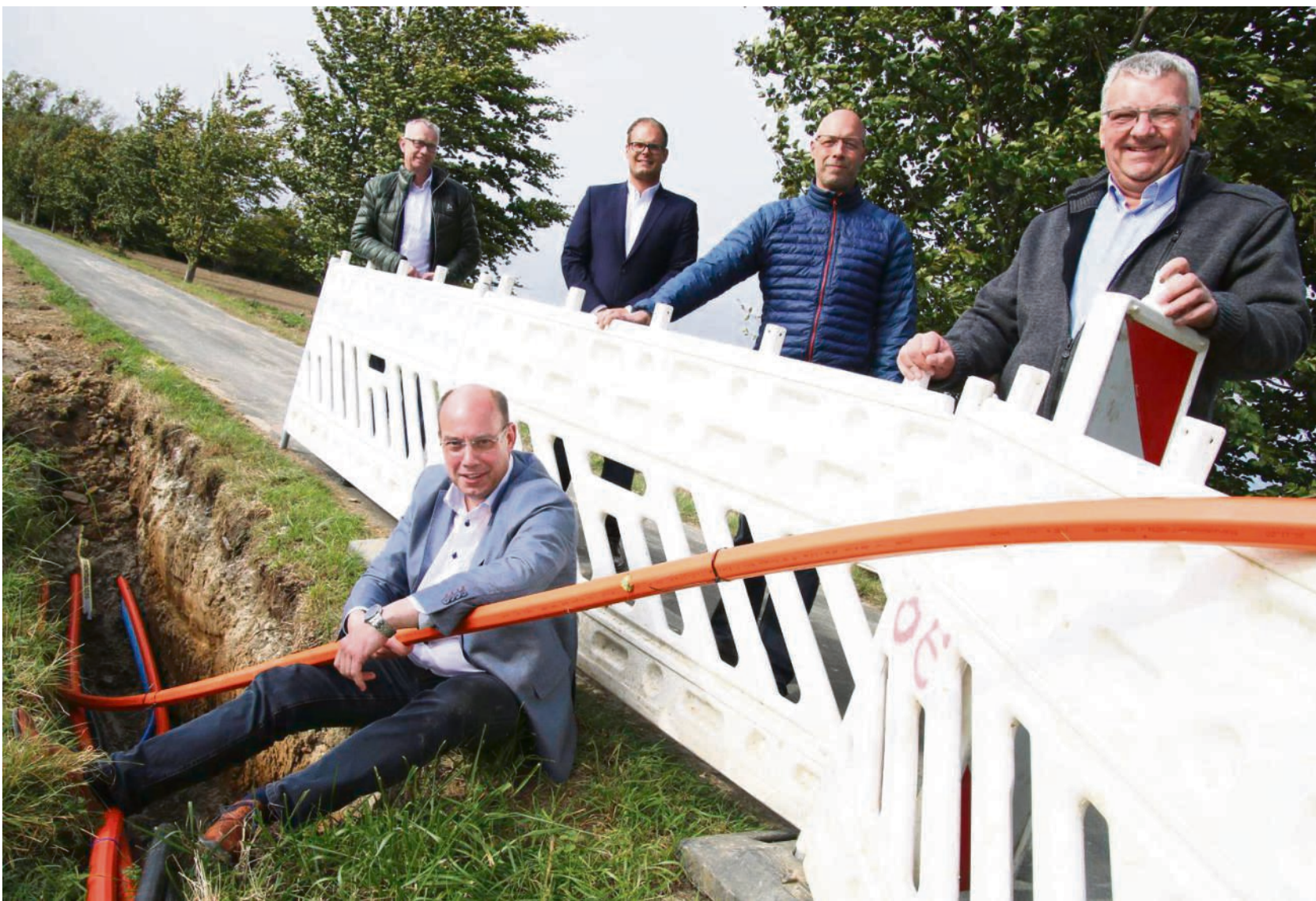
Glasfaser geht übers Land: Zum Start des geförderten Breitbandausbaus im ganzen Stadtgebiet trafen sich in Oestereiden Bürgermeister Peter Weiken (vorn) sowie Beigeordneter Hubert Betten, Johannes Kobeloer und Heiko Grebe von Westenergie und Ortsvorsteher Alfons Levenig. FOTO: SCHÖNHENSE
