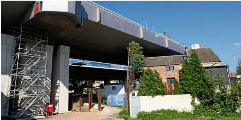
Die ersten Teile der neuen A 40-Rheinbrücke in Duisburg – hier auf Homberger Seite – werden Richtung Ufer geschoben.
