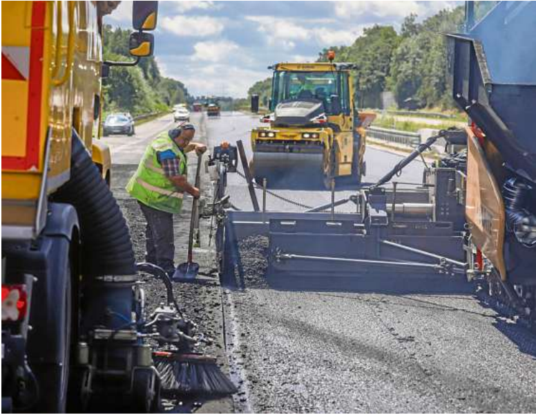
Auf der A40 zwischen Mülheim und Duisburg wird in den Herbstferien in Fahrtrichtung Venlo Flüsterasphalt verlegt.
