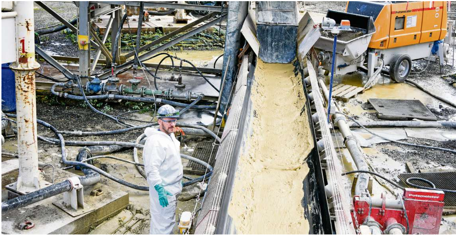
Am Förderband für den Beton zur Schachtverfüllung: Vor fast drei Jahren wurde auf Prosper-Haniel die letzte Steinkohle gefördert. FOTOS: VON STAEGMANN / FFS
