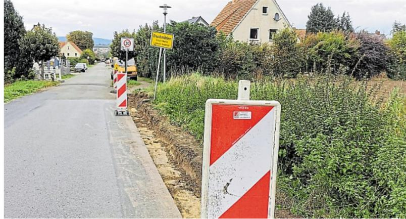
Der Hünenburgweg in Bruchmühlen ist wieder streckenweise voll gesperrt; die Absenkung des Straßenrandes muss befestigt werden.
