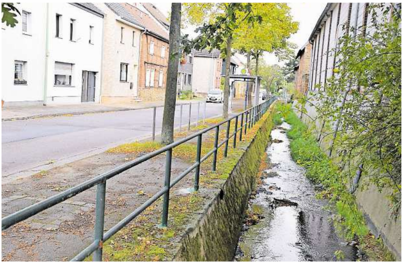
Normalerweise ist auch der Birgeler Bach nicht mehr als ein Rinnsal, Mitte Juli aber wurde die Bachstraße in Birgel überflutet, Keller liefen voll. FOTO: JÖRG ABELS
