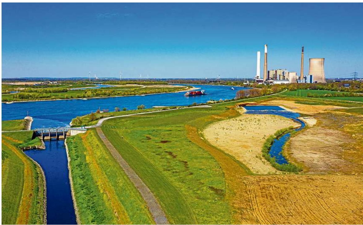
Der Emscherdeich wäre auch vom Hochwasser betroffen gewesen. Die Emscher soll künftig durch eine Auenlandschaft mäandern – der neue Verlauf ist schon gut zu sehen.
