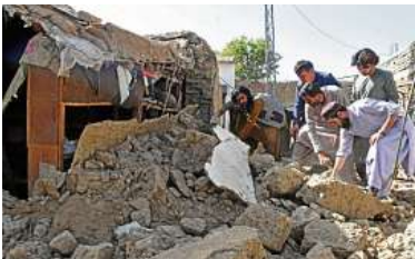
Suche nach Überlebenden in den Trümmern.
