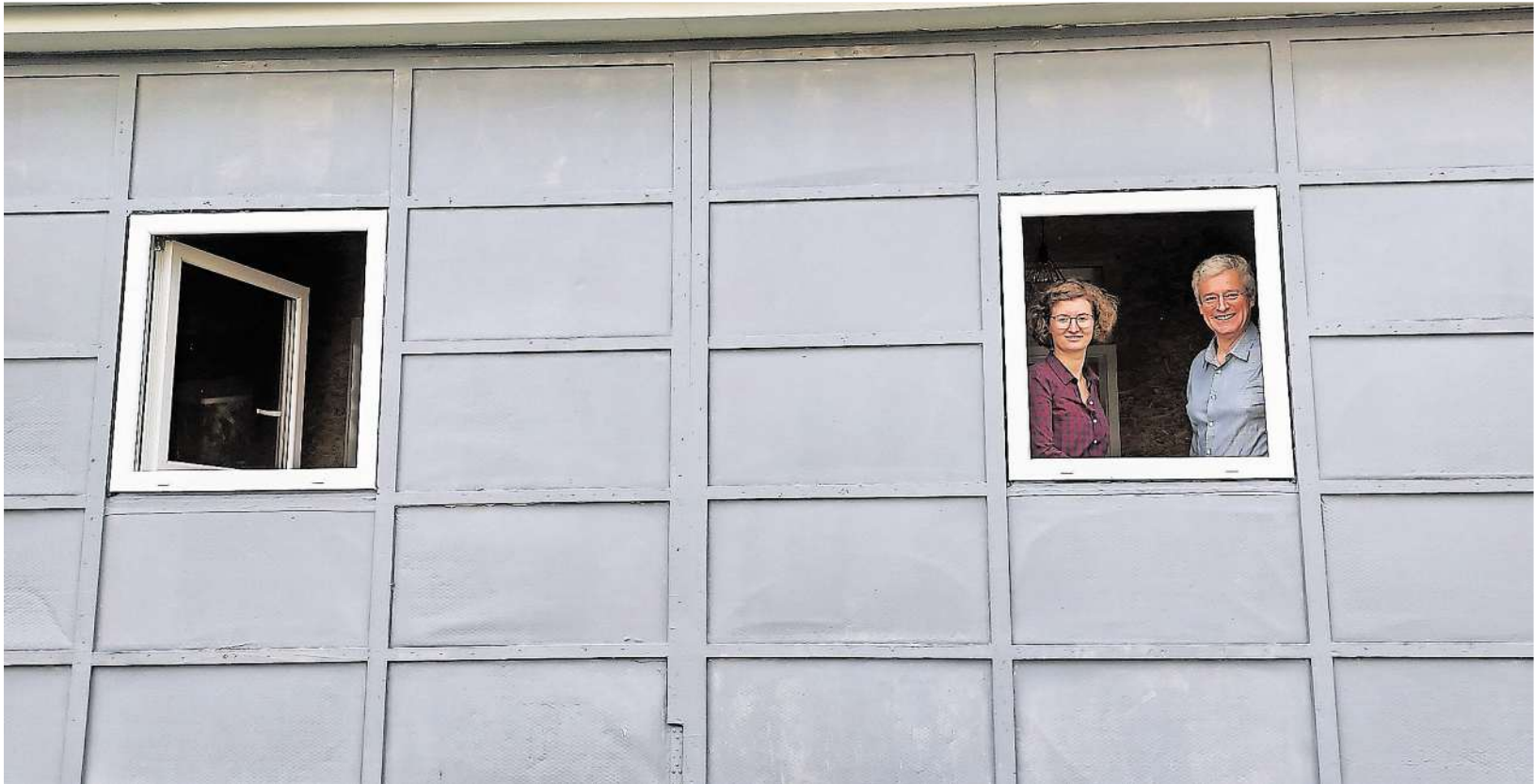
Die promovierte Ingenieurin Magdalena Kimm (30) von der RWTH Aachen und der Ingenieur Andreas Mohr (60) arbeiten gemeinsam an standardisierten Bauelementen mit integrierter Isolierung. In nur einer Woche entsteht so ein vollständiges Einfamilienhaus.
