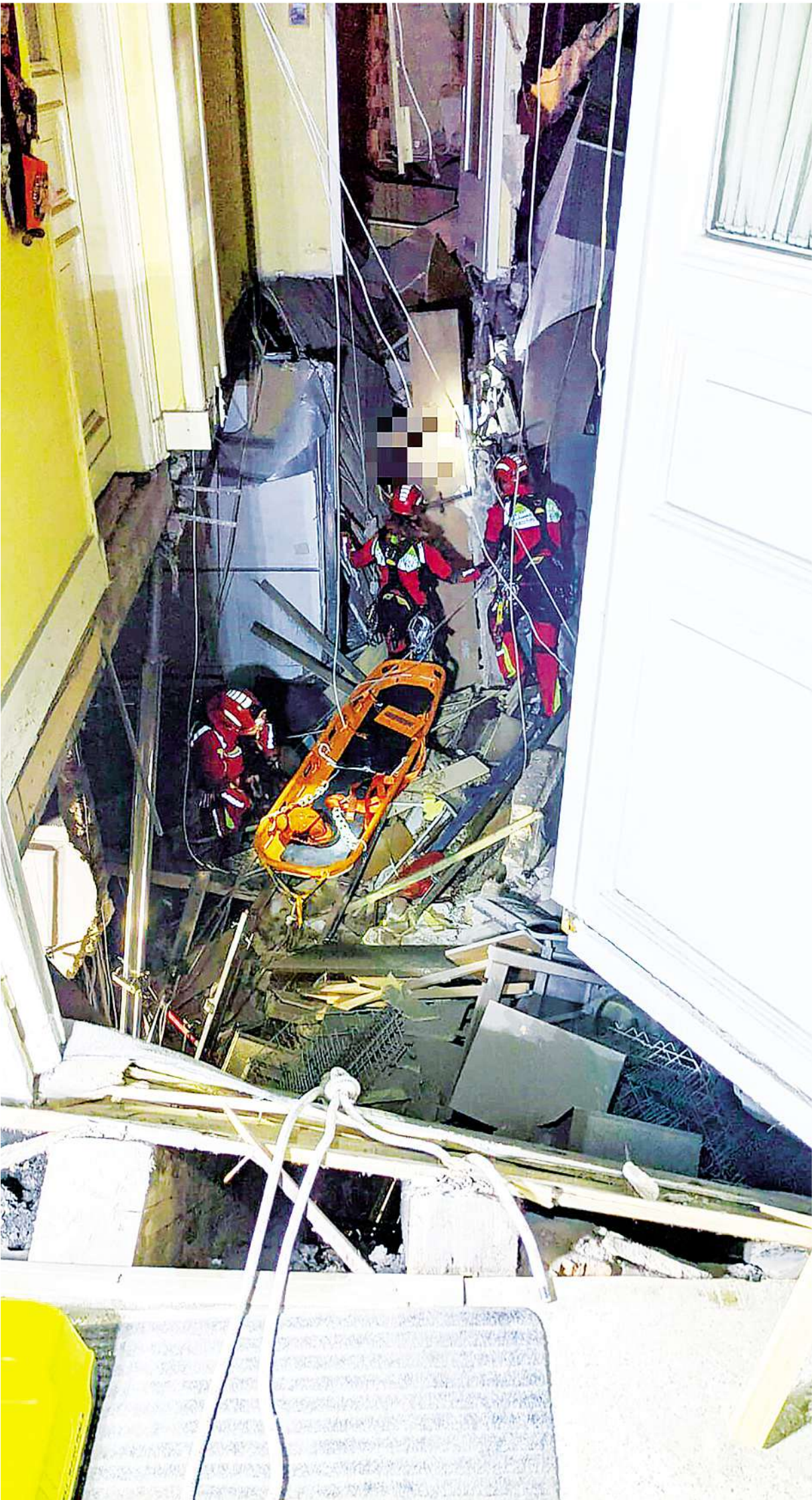
Blick aus dem Treppenhaus aufs Einsatzgeschehen: Ein Team aus drei Leuten versucht, die eingeklemmte Frau zu befreien.
