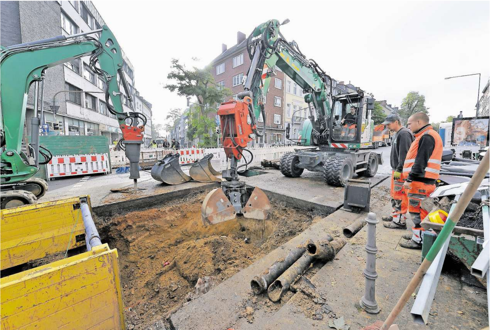
Schwerstarbeit nicht nur für die Bagger – und eine heftige Nervenprobe für Verkehrsteilnehmer: Wegen der Großbaustelle inmitten der Wilhelmstraße müssen Autofahrer derzeit lange Umwege und reichlich Staus in Kauf nehmen.
