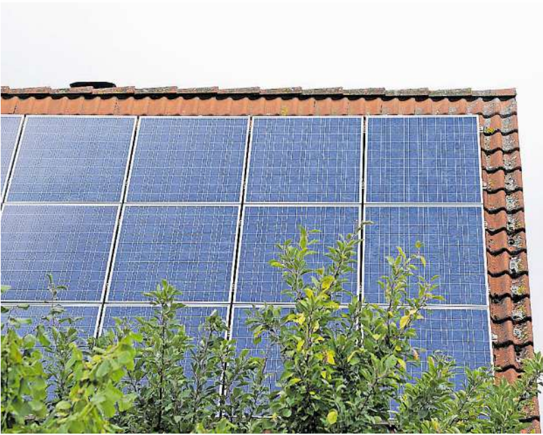
Aachen macht ernst: Für Neubauten soll bald eine Solardachpflicht gelten.
